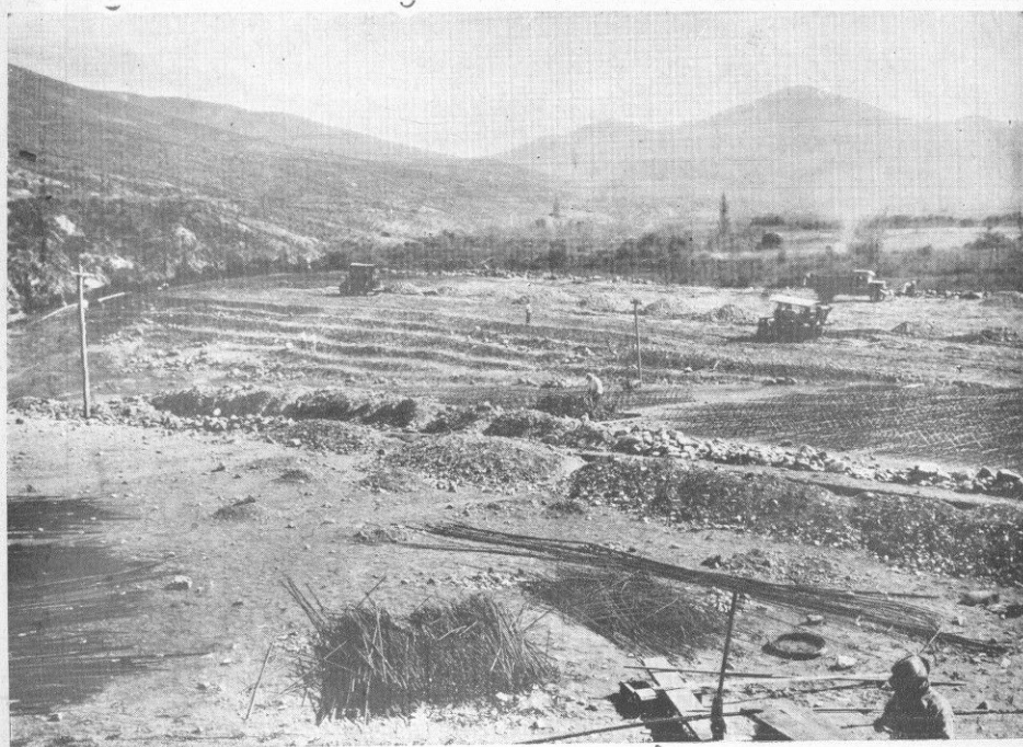
Terraplén del Tranque
