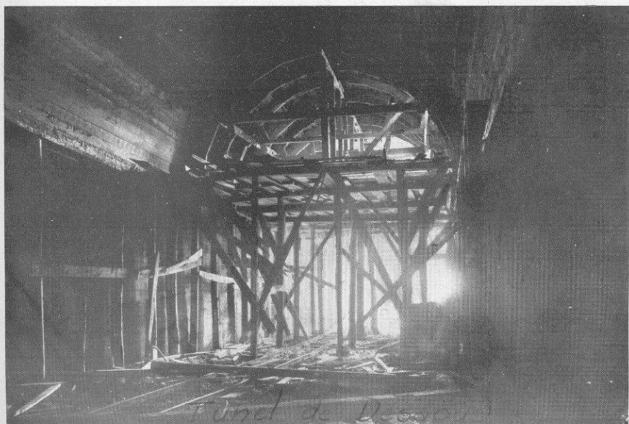
Túnel de Desagüe
