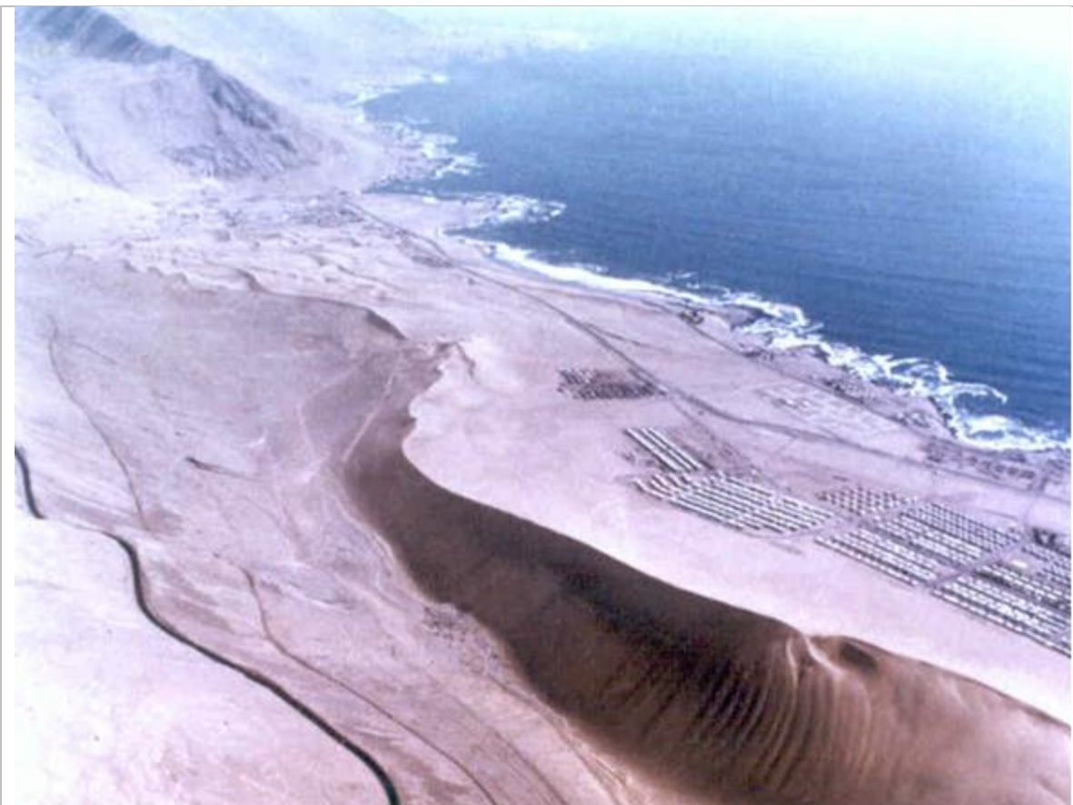
2.2.- Vista general de las poblaciones construidas en el pie occidental de la gran duna Cerro el Dragón, Iquique, sometidas a fuertes procesos deflacionarios (extracción y transporte de arenas por el viento) con graves problemas para las viviendas, redes de servicios básicos y personas. Foto: gentileza de Edgardo Gaete.
