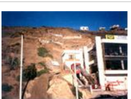
Fig. 2.1. Desestabilización de dunas en acantilado costero por excavación en su frente, generando condiciones de alto riesgo para las edificaciones localizadas tanto en el borde superior como en el inferior. Camino costero Concón-Reñaca.
