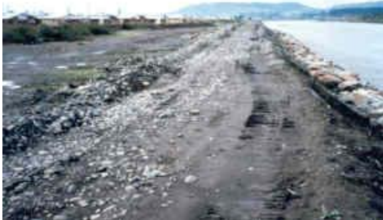
Fig.3.1.-Población construida en el lecho fluvial ocupado por el río Cautín en períodos de altas aguas medias. Se observa similar nivel entre el terreno (piso de las casas) y la superficie de las aguas. Defensa: muro de ripio y arena compactado, con malla plástica y enrocado en su frente expuesto.
