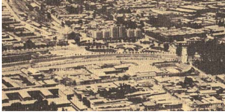
Fig.1. Acometida del Parque Gómez Rojas en calle Pío Nono, c. 1929 (a la derecha de la fotografía). Fte.: Sección de fotografía en: LEHMANN DE IZQUIERDO, Antonia y MÉNDEZ B., Ramón Alfonso. La ciudad y sus arquitectos. Concurso de Anteproyectos Plaza Baquedano , Santiago de Chile, Ed. Universitaria S.A., 1982, 76 págs.
