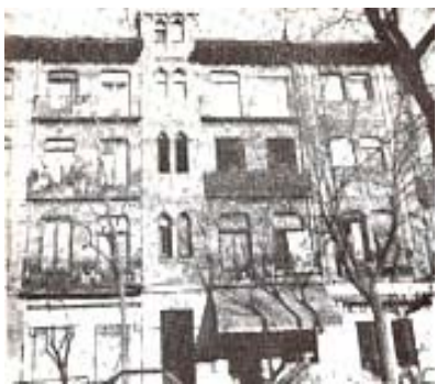
Fig. 3. Anexo 1.- Edificio de viviendas -arquitectura neomudéjar- ubicado en calle de Galileo N°34; c/v Meléndez Valdés. Autor: R. Cuadrillero (maestro de obras) A., año 1915.
