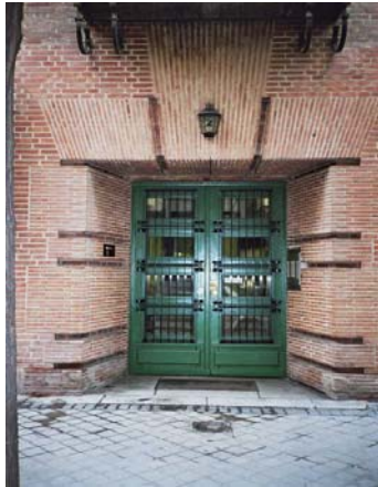
Fig. 28. Detalle de acceso residencial por calle de Hilarión Eslava. Foto. M.I.P., 2006. ©
