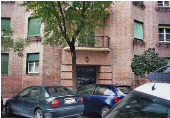
Fig.26. Acceso residencial remarcado mediante quiebre de la fachada. Foto. M.I.P., 2006. ©
