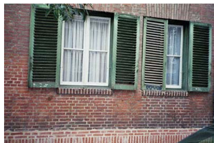
Fig. 34. Ventanas a calle con marcos y postigos de madera originales en planta baja. Calle de Meléndez Valdés. Foto. M.I.P., 2006. ©
