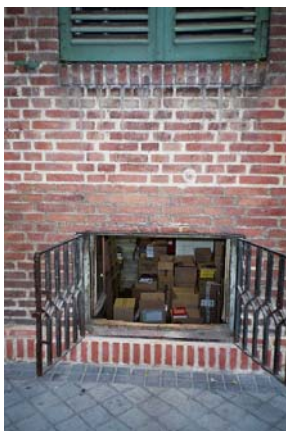
Fig. 32. Ventana para ventilación de recinto soterrado ocupado como bodega. Fachada en calle de Hilarión Eslava. Foto. M.I.P., 2006. ©
