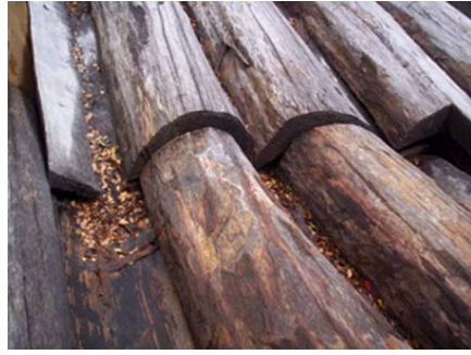
Fig. 20. La canoga, además de utilizar una manera de construir en vías de desaparecer, aporta una impronta estética y ritmo propio del lugar y una sencillez constructiva al momento de realizar la obra.
