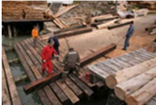
Fig. 16: Reparación el muelle construido en ciprés.
