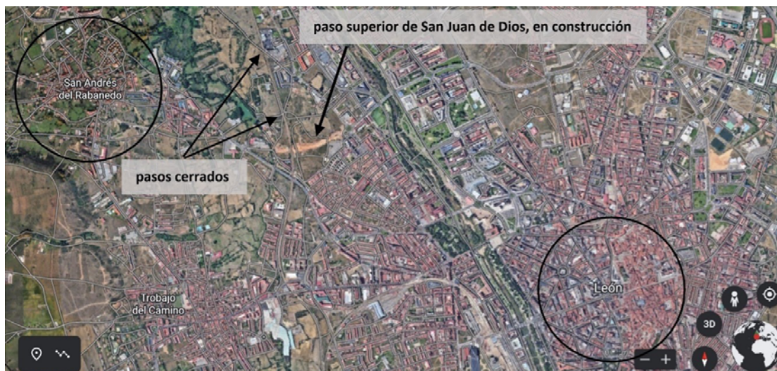
Figura 8 San Andrés del Rabanedo y León con el paso superior en construcción
