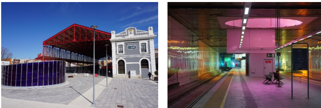
Figura 6 Paseo superior con lucernarios y andenes soterrados bajo la marquesina histórica
